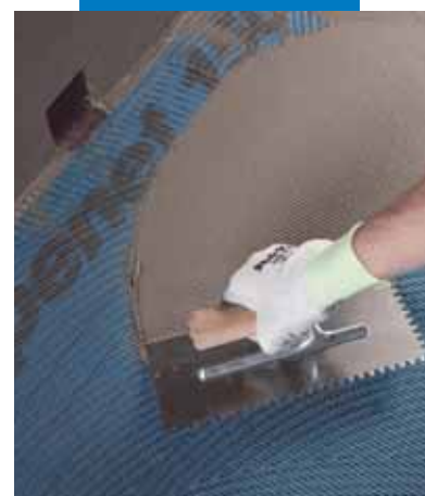
Laying Mapelastic on Mapenet 150
